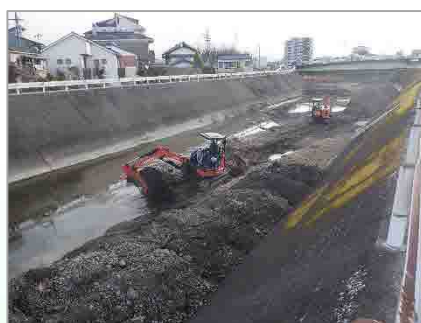
堆積した土砂の浚渫
