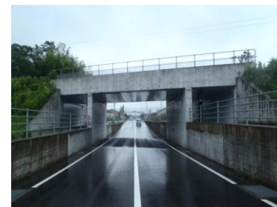
大型カルバート（山田架道橋）
