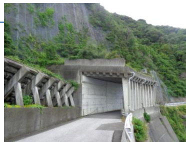
シェッド（安和洞門1）
