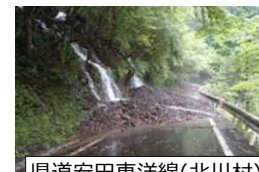
県道安田東洋線(北川村)
