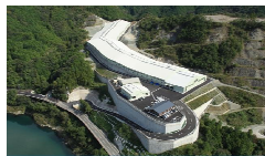
平成23年10月開業 (埋立容量:約11万 3 m)
