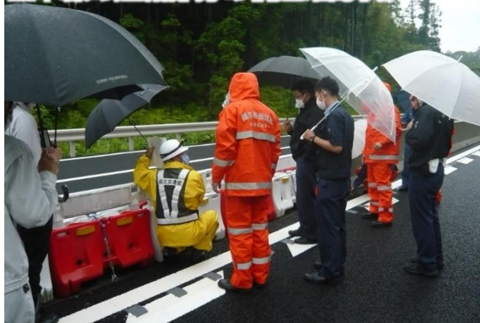
上下線の連絡部分の構造確認状況
