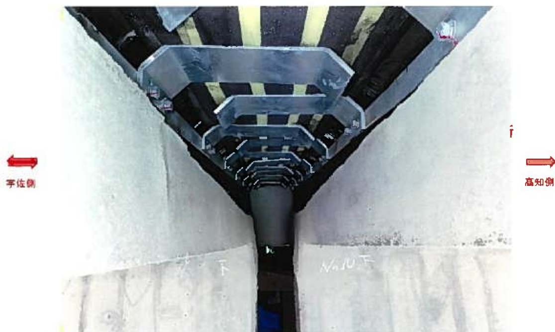
仁淀川河口大橋 伸縮装置止水工 乾式止水材設置完了(P10-P11径間 下流側)
