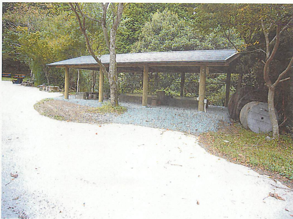
完成写真 炊事棟東南面
