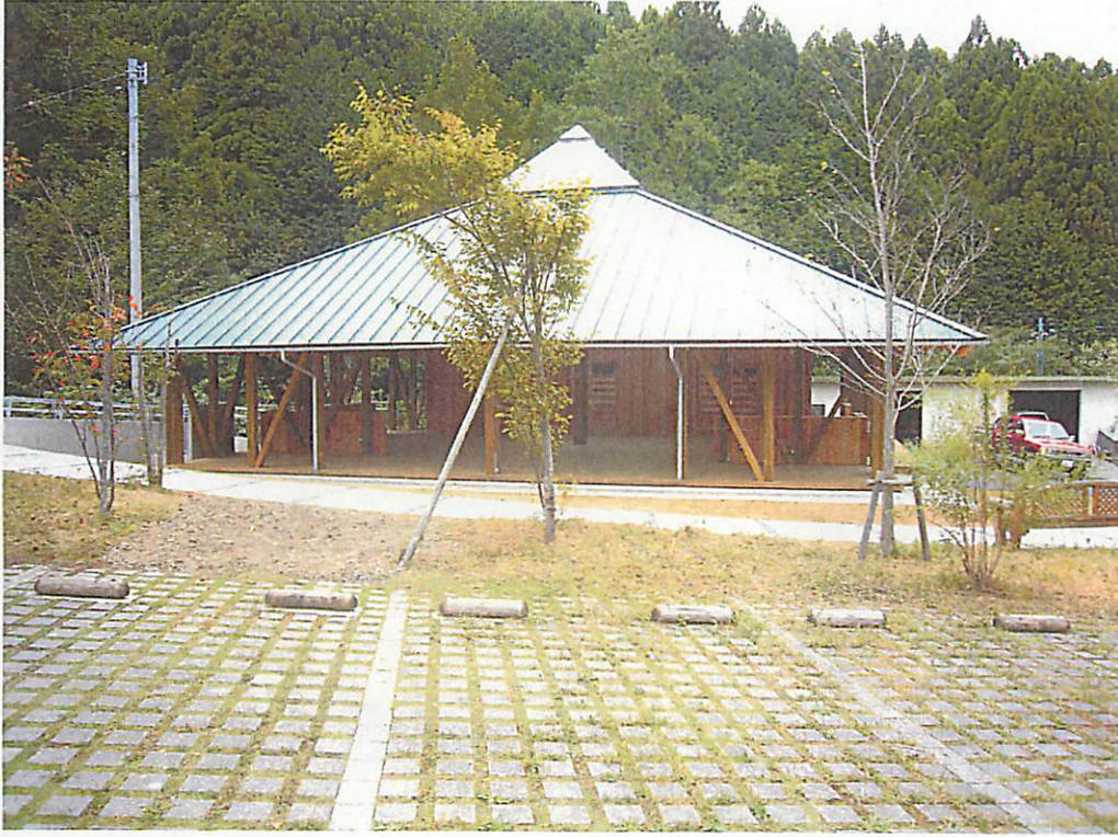
完成写真 研修棟南面
