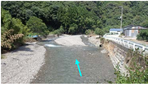
河床掘削(安芸川支川尾川川・安芸市)
