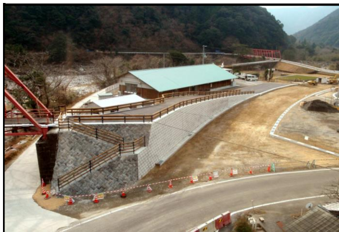
道交国(特改)第18-001-1号 国道493号 地域活力基盤創造交付金工事
