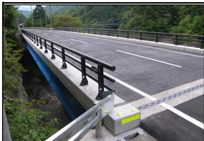
道交国(特改)第28-003-1号 国道194号 地域活力基盤創造交付金(角堂橋拡幅)工事
