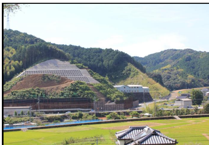
道交国(改築)第21-028-6号 国道494号 地域活力基盤創造交付金工事
