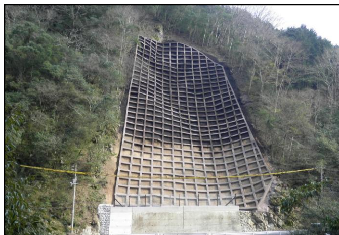
道交地自主(防災)第14-107-2号 県道中平橋原線 地域自主戦略交付金工事
