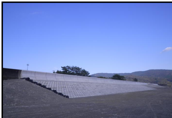
港高潮第2-3号 奈半利港海岸高潮工事
