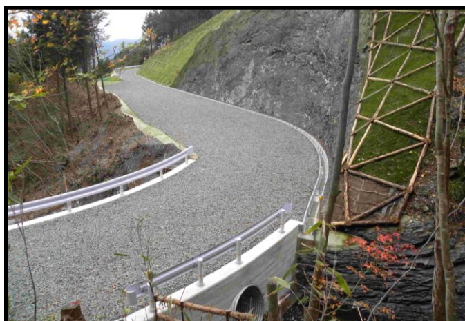
道交基幹第77号 森林基幹道開設事業 寒風大座礼東線1工区工事
