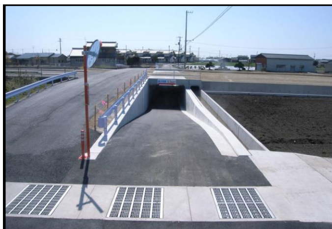
道交国(改築)第21-054-25号 国道195号 地域活力基盤創造交付金工事
