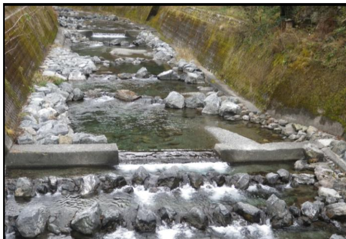
河改(交)第4-9-1号 狩山川河川改修交付金工事
